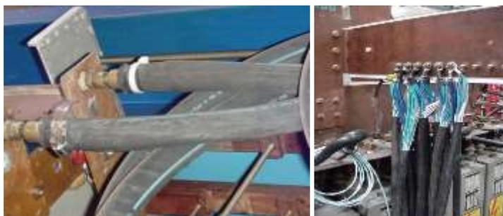
Figure 6 : Exemple de câbles refroidis à l'eau et câbles secs.
